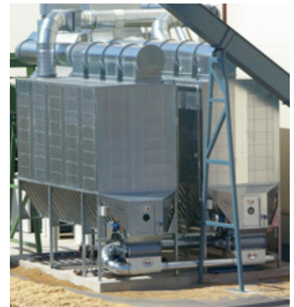
FS-filter passar för applikationer där stora volymer heta rökgaser ska filteras.
